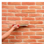
3 - Applico l'idrorepellente solo per l'esterno
