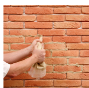
2 - rimuovo il supplemento di colla
